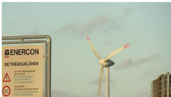
An den Betontürmen von 75 Windkraftanlagen von Enercon wurden Risse entdeckt. (Archivbild)
