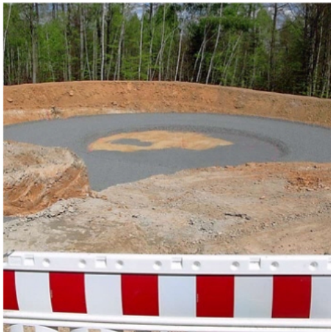
So sieht eine Fundament-Grube für ein einzelnes Windrad im Wald aus. Archivfoto: Götz Schaub
